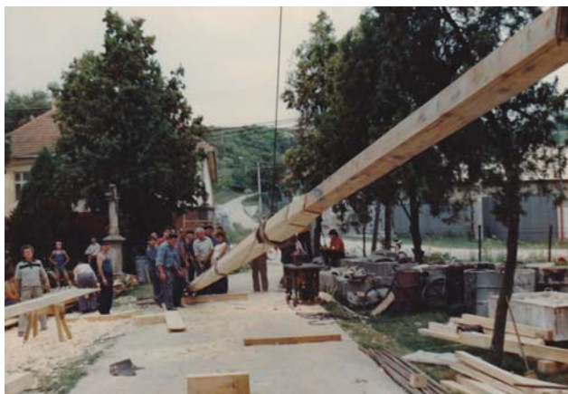
Výmena krovu na kostolnej veži (r. 1990)
